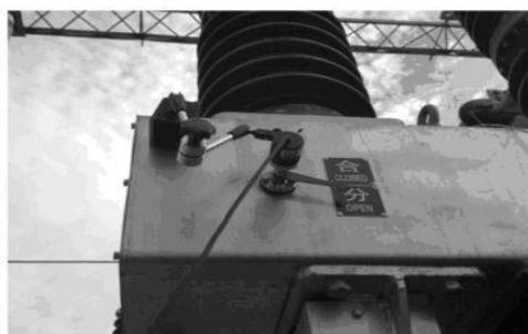
35KV SF6 开关传感器安装
